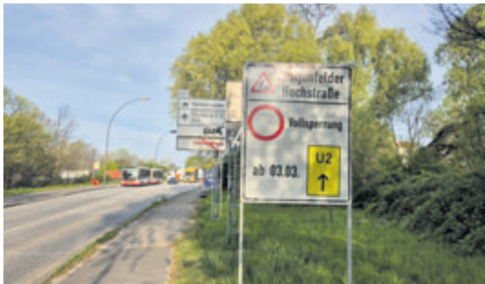
Seit März vergangenen Jahres wird die Klütjenfelder Hochstraße bereits saniert Foto: au
