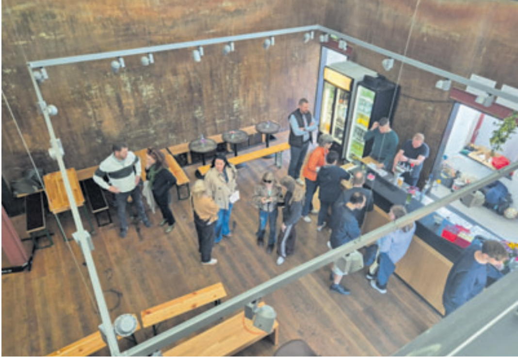
Im Innern des Verdüsungsbauwerks sind deutlich die Eisen- und Mangan-Ablagerungen zu sehen, die dem Gebäude eine einzigartige Atmosphäre verleihen Fotos: au
