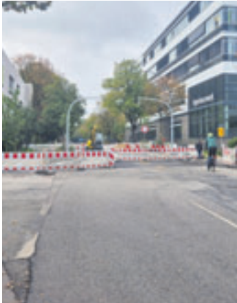
Zumindest die Baustelle zwischen Trettaustraße und Kurdamm soll bis Oktober 2026 fertiggestellt sein Foto: au
