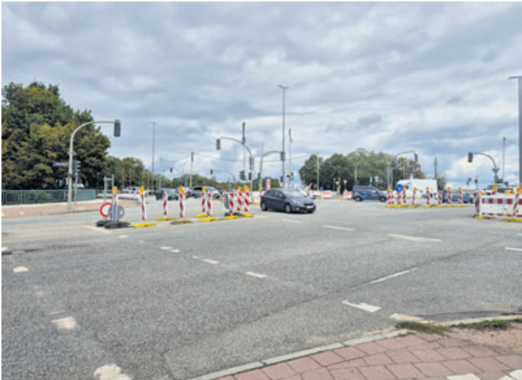
Der Harburger Doppelknoten wird in den kommenden Monaten umgebaut. Die Verkehrsteilnehmer müssen sich auf erhebliche Einschränkungen einstellen Fotos: au
