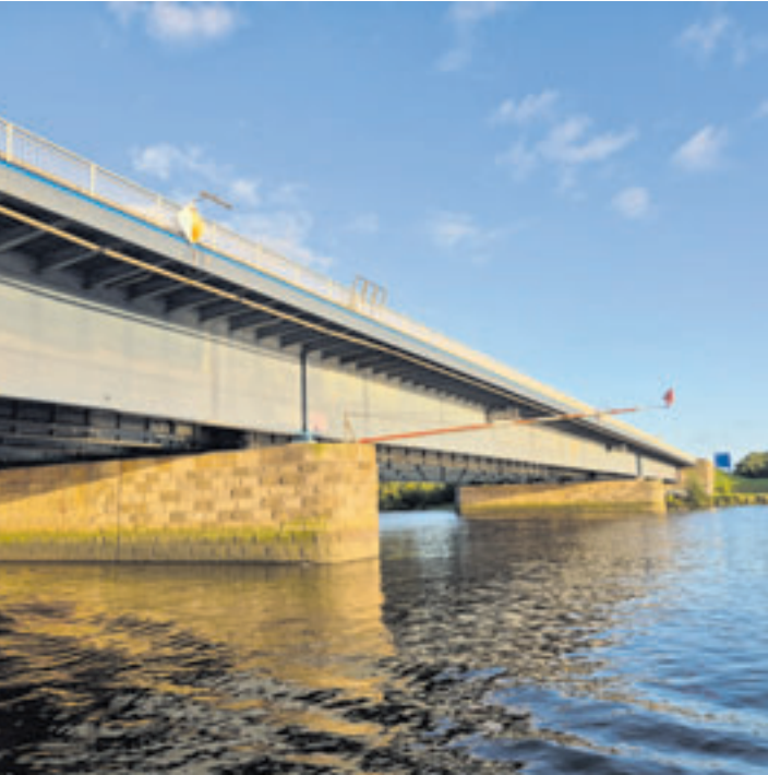
Für den Ersatzneubau der Süderelbbrücken sind zahlreiche vorbereitende Arbeiten notwendig Foto: au
