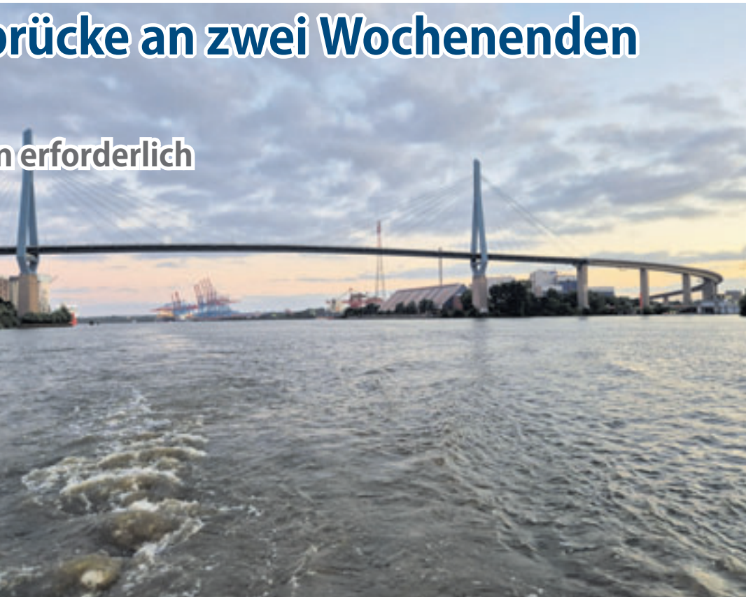
Im September muss die Köhlbrandbrücke gleich an zwei Wochenenden voll gesperrt werden
