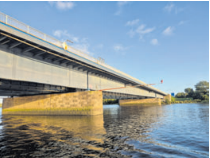
Die Süderelbbrücke muss erneuert werden. Derzeit finden zahlreiche vorbereitende Arbeiten statt Foto: au
