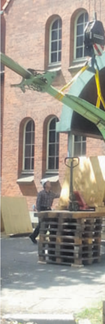
Der Engel wurde vom Dach aus direkt in die Kirche hineingehoben
