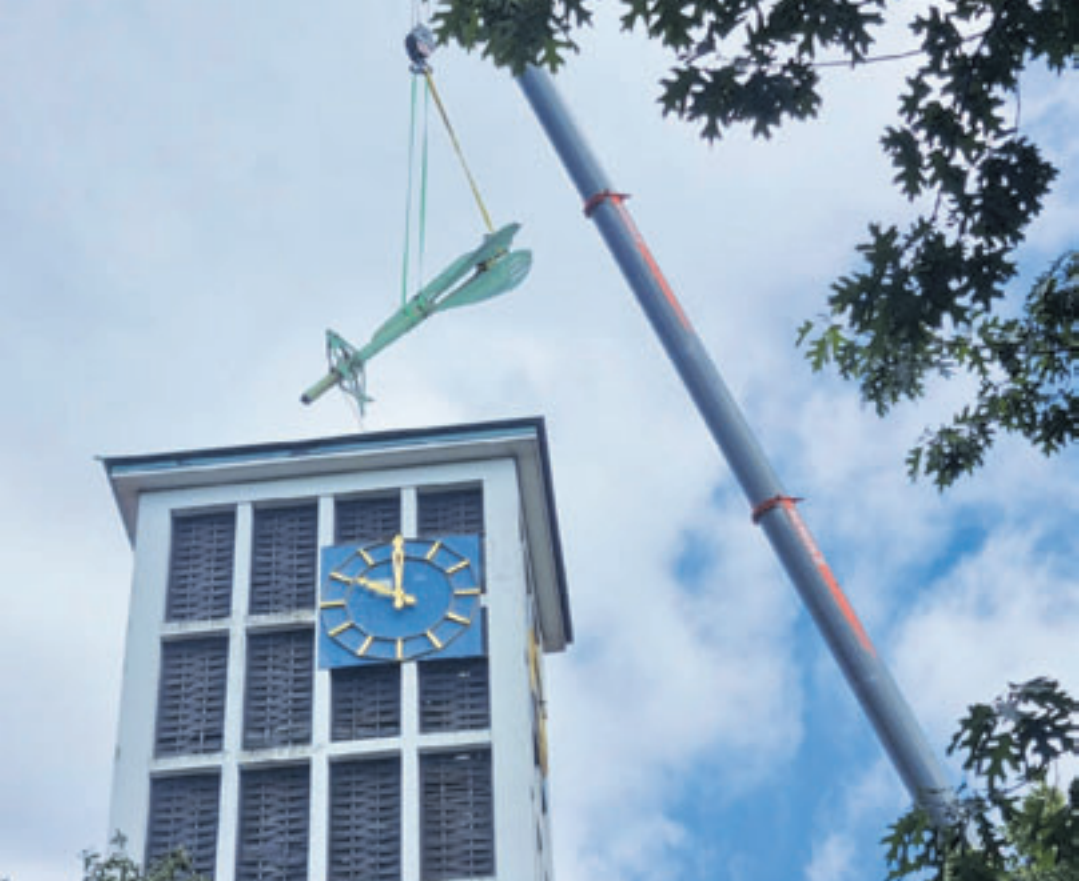
Mit einem Kran wurde die Figur aus Sicherheitsgründen vom Dach gehoben
