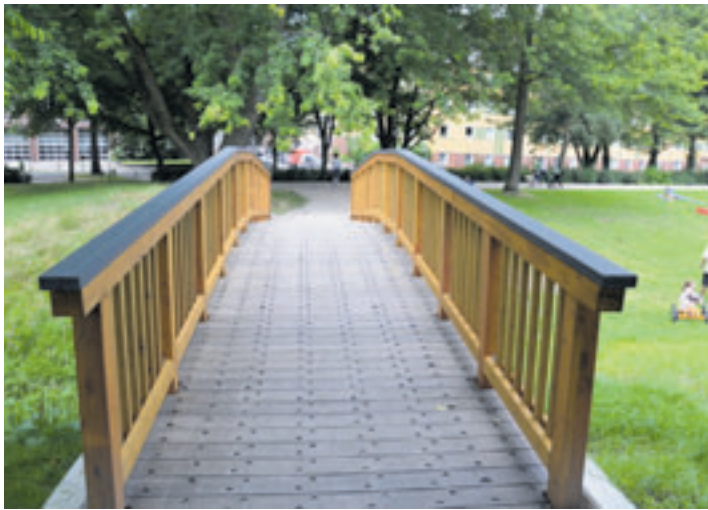
Die neue Holzbrücke kann laut Bezirksamt nicht nach Niels Stensen benannt werden. Foto: mk
