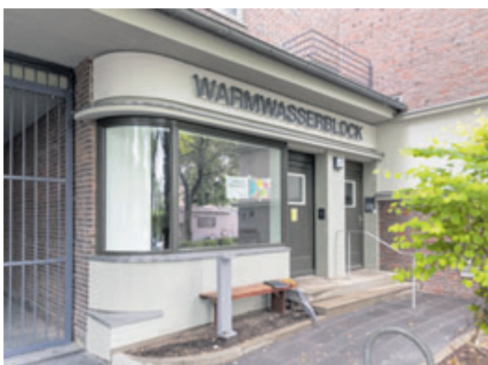
Beim Warmwasserblock handelte sich um das erste Gebäude auf der Veddel mit fließend warmem Wasser für die Bewohner
