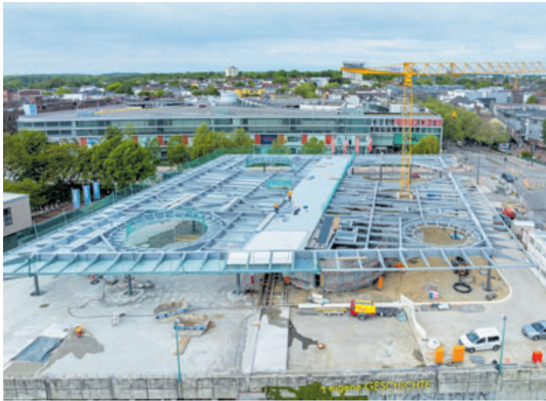
Die Tragstruktur der künftigen Dachkonstruktion der neuen Busanlage ist inzwischen weitestgehend errichtet Fotos: Hochbahn
