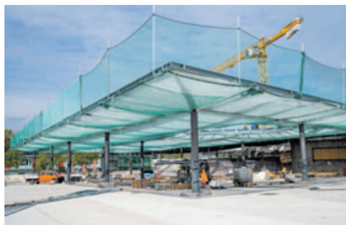
Die insgesamt 23 Stahlstützen, die jeweils rund drei Tonnen wiegen, bilden das tragende Gerüst der Anlage und tragen mit einer Höhe von bis zu 6,5 Metern künftig das Dach
