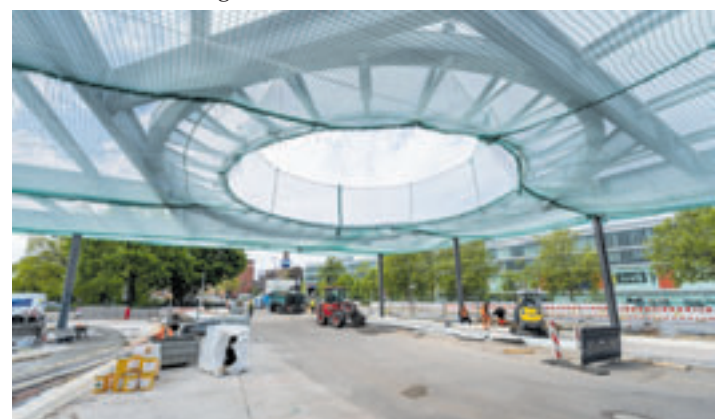
Die Tragstruktur der künftigen Dachkonstruktion der neuen Busanlage ist inzwischen weitestgehend errichtet
