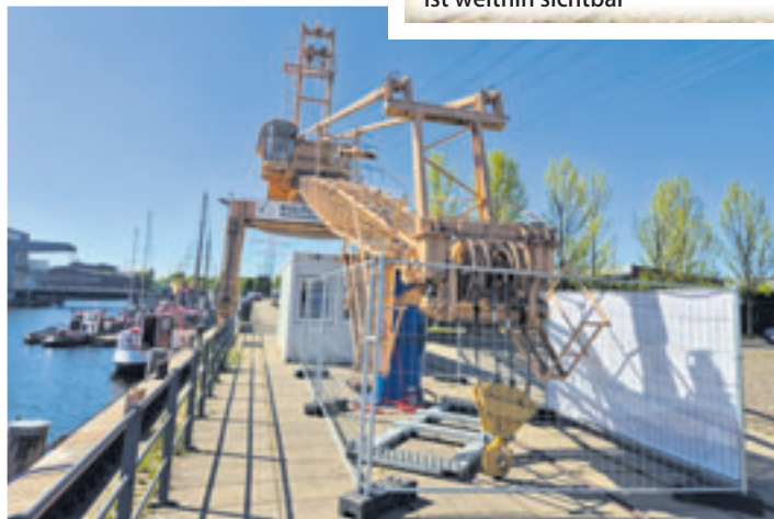
Zum offiziellen Baustart wurde der riesige Ausleger abgeseht
