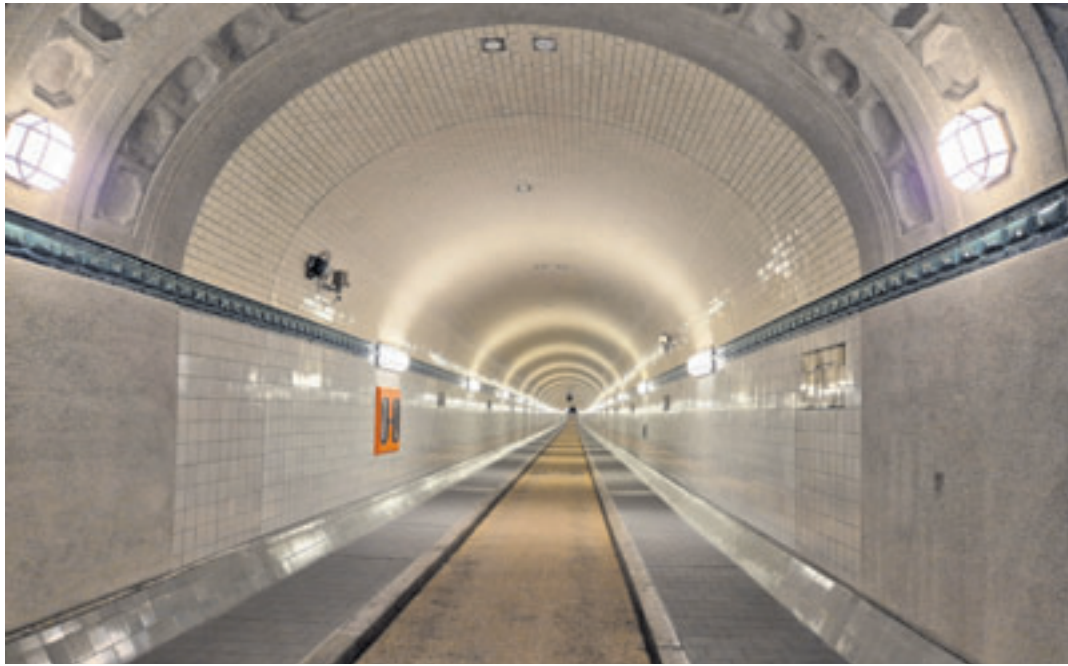
Bei der denkmalgerechten Sanierung wurde ein besonderes Augenmerk auf die Fliesen und Reliefs gelegt, die die Entstehungsgeschichte des Tunnels erzählen
