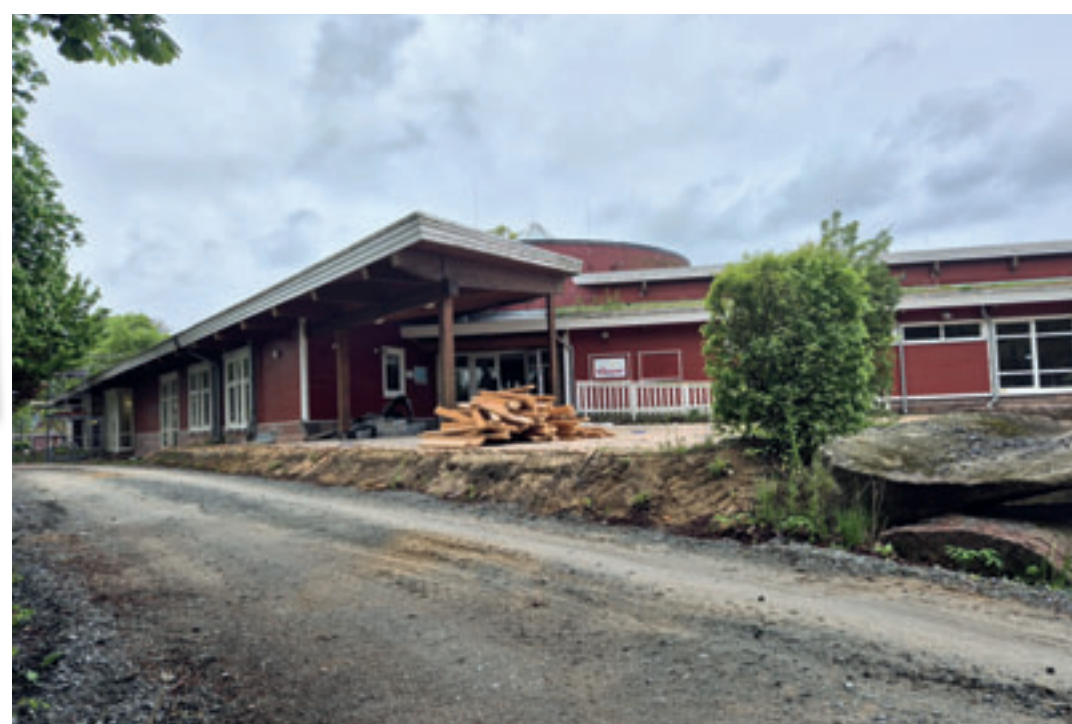
Erst im dritten Quartal 2028 soll das Schwimmbad MidSommerland vollständig eröffnet werden Fotos: au
