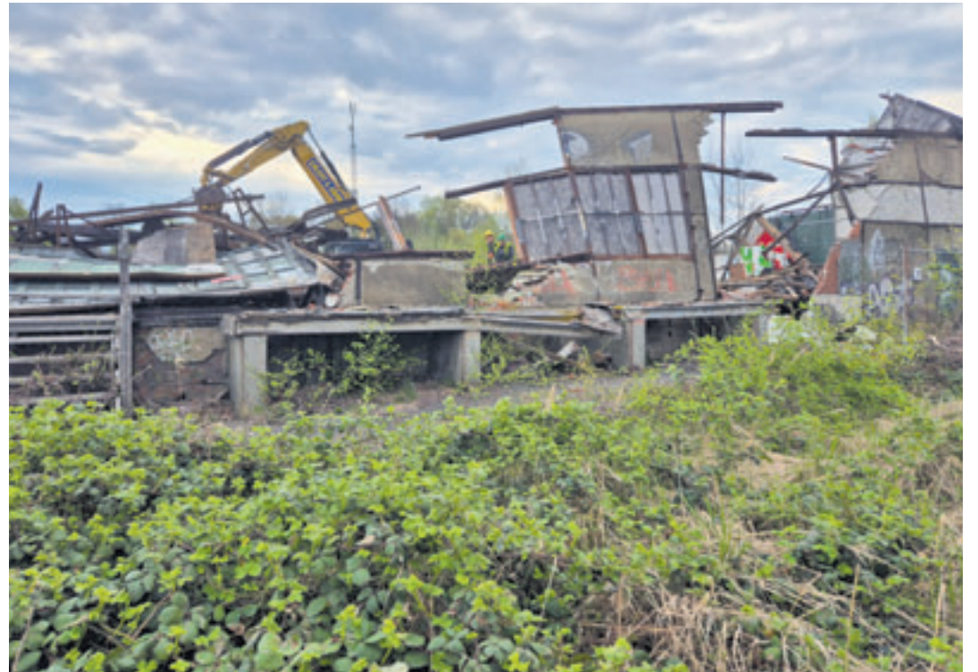
Am Montagmorgen der vergangenen Woche rückten in aller Herrgottsfrühe die Bagger an und haben mit dem Abriss der maroden Lagerhalle angefangen
