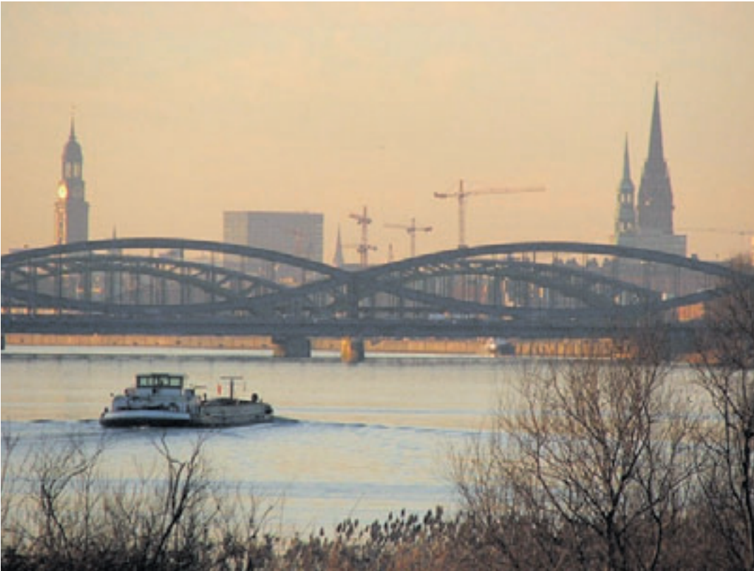
Nachdem die Fahrbahn der Neuen Elbbrücken in den vergangenen Monaten stadteinwärts saniert wurde, folgt nun die andere Seite Foto: PublicDomainPictures
