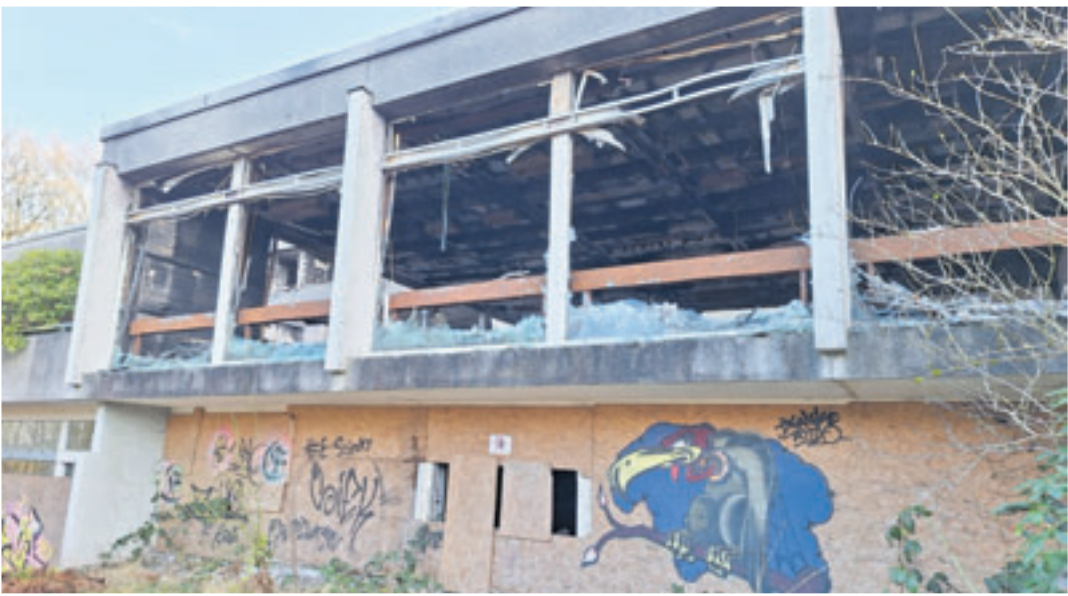
Das leerstehende Berghotel ist nach den Bränden nur noch eine Ruine
