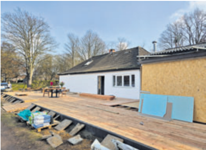
Im Inneren und rund um das Bootshaus an der Außenmühle wird noch fleißig gewerkelt. Nur noch wenige Wochen, dann soll eröffnet werden
