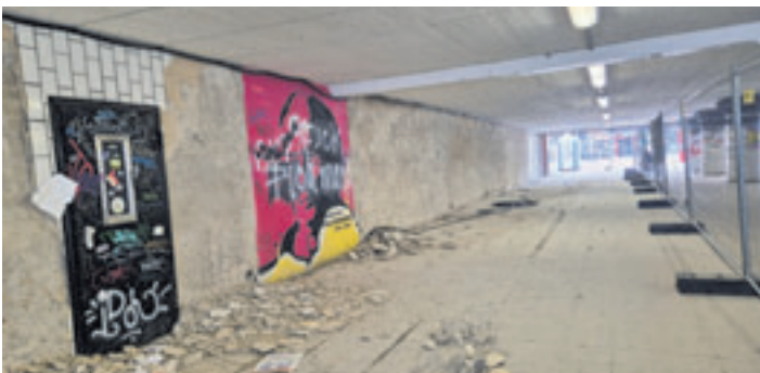
Bevor das Neue schön wird, muss das Alte ab, wie hier die beschädigten Wandfliesen im Tunnel Foto: au
