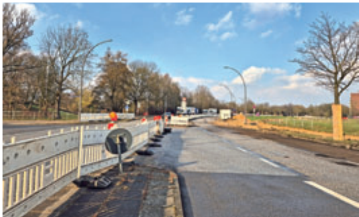
Seit vergangener Woche wird auf der Otto-Brenner-Straße gebaut. Hier entsteht ein Teil der Radroute 23
