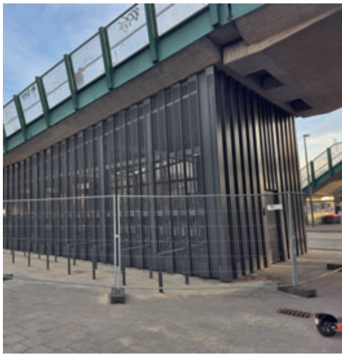
Die neue Radstation unter der Muharrem-Acar-Brücke soll Anfang April fertiggestellt werden Foto: au
