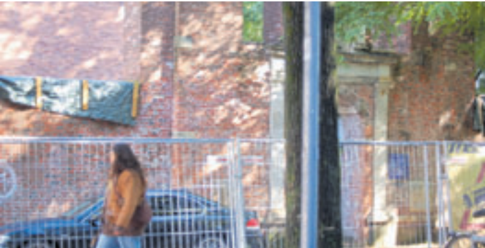
In der Neuen Straße wird aktuell die denkmalgeschützte ehemalige Dreifaltigkeitskirche zu einer Kindertagesstätte umgebaut Foto: mk
