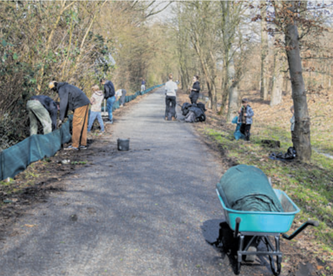
Packten gemeinsam für den Amphibienschutz an: Freiwillige, Mitarbeiter des Inseelparks und der BUND Hamburg bauten einen rund einen Kilometer langen Schutzzaun
