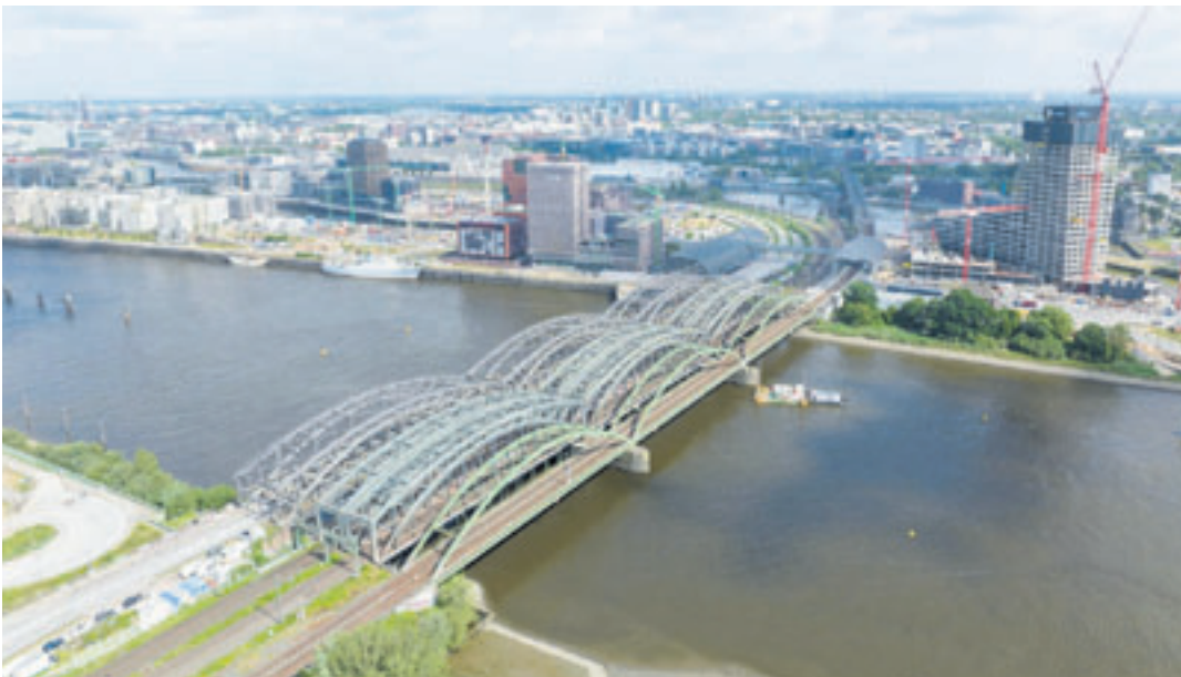
Die Eisenbahnbrücke über die Norderelbe: Derzeit führen vier Gleise über das Gewässer. Links daneben die Freihafenelbbrücke, die aufgrund eines Unfalls gesperrt ist Foto: Deutsche Bahn AG
