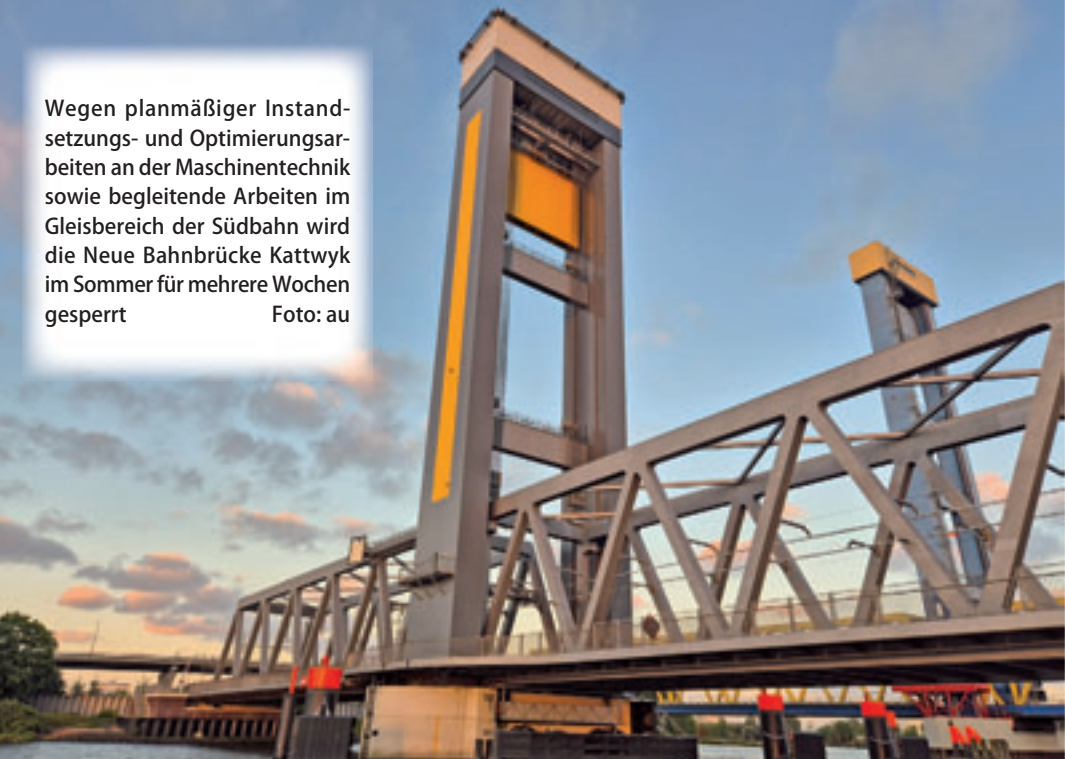
Wegen planmäßiger Instandsetzungs- und Optimierungsarbeiten an der Maschinenteknik sowie begleitende Arbeiten im Gleisbereich der Südbahn wird die Neue Bahnbrücke Kattwyk im Sommer für mehrere Wochen gesperrt Foto: au
