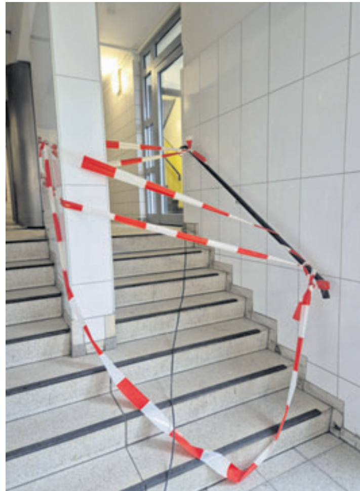
Montagmorgen im Erlerring 10: Die Arbeiten laufen auf Hochtour Foto: au
