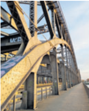
1926 wurde die Freihafenelbbrücke erbaut und gilt laut Denkmalverein als besondere Konstruktion Foto: au
