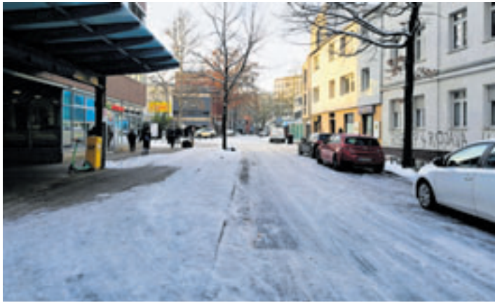
Sowohl der Bürgersteig als auch die Fahrbahn sind am Wall völlig vereist
