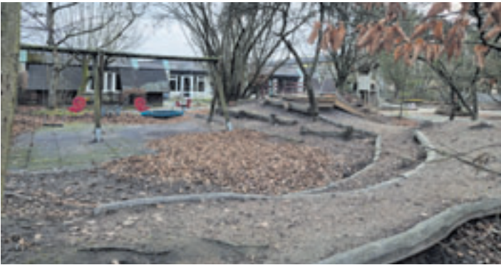
Ein Teil der Kita Elfenwiese ist bereits gesperrt, im September dieses Jahres soll die Kita ganz geschlossen werden. Grund ist ein Marderbefall des Gebäudes
