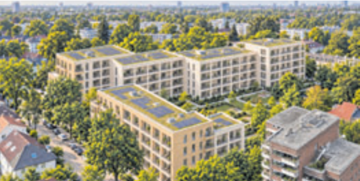
Gestalterisch prägen helle Fassaden zur Straße und durchlaufende Balkone zum begrünten Innenhof die „Neugrabener Höfe“
