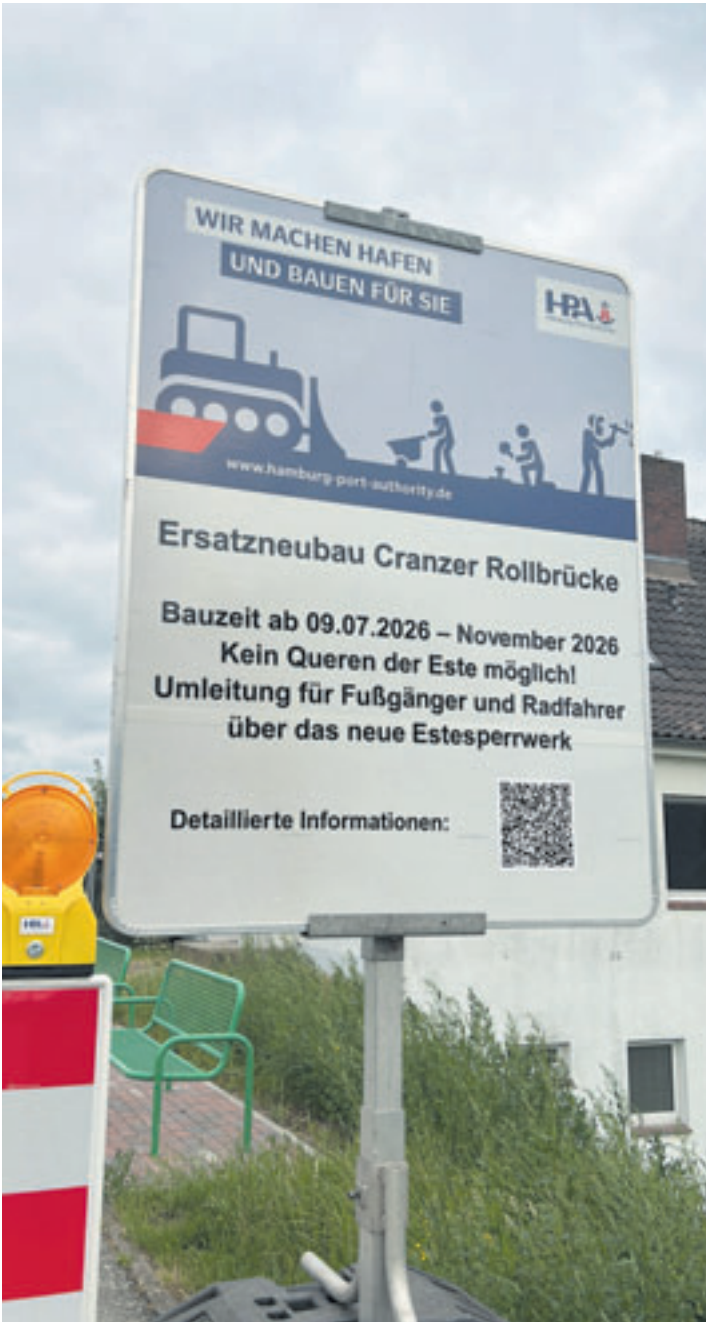
Die Vorschläge des SPD-Distriktes Neuenfelde für alternative Umleitungen wurden von der Behörde allesamt abgelehnt Foto: SPD Neuenfelde
