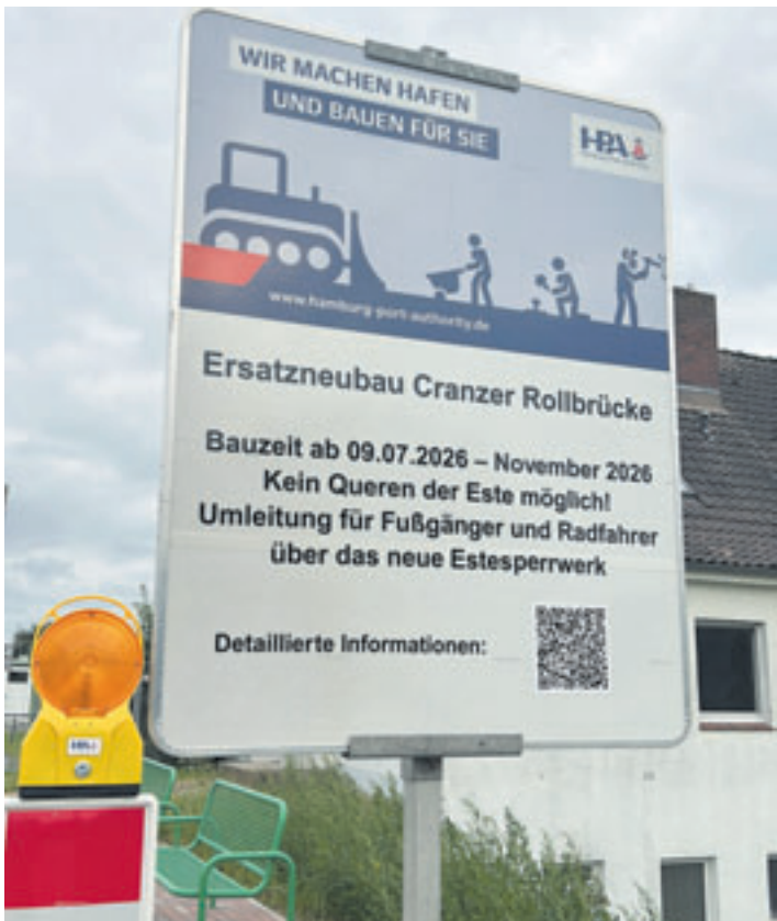
Während der Bauarbeiten an der Cranzer Rollbrücke am Alten Estesperrwerk ist die Haltestelle Altes Estesperrwerk für die Neuenfelder nicht nutzbar Foto: SPD Neuenfelde
