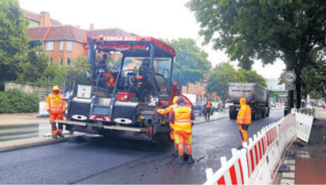
Stück für Stück wird die B73 in Neugraben saniert
