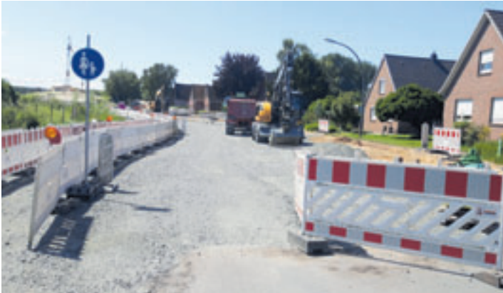
Anwohner der Francoper Straße zwischen Hinterdeich, Emmi-Ruben-Weg und Hohenwischer Straße müssen sich noch eine Weile gedulden, bis sie diesen Teil der stark frequentierten Trasse wieder mit Fahrzeugen benutzen können
