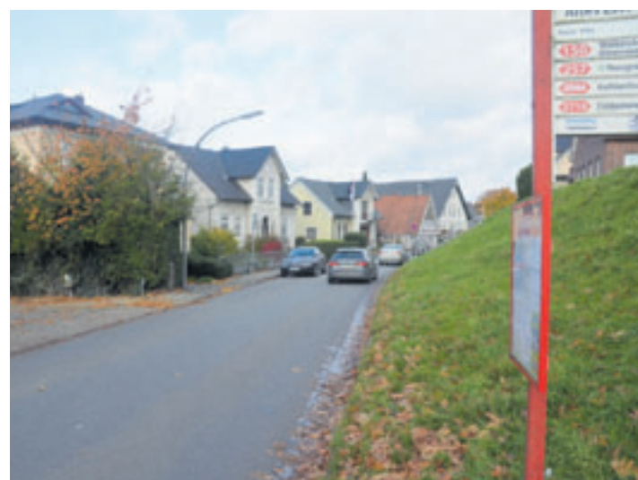
... oder im Estedeich in Cranz: Wegen Rohrbrüchen mussten die Straßen gesperrt werden
