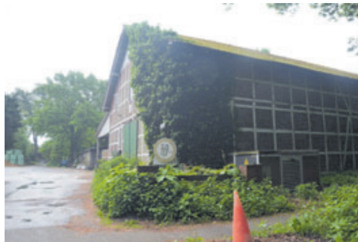
Die Bewohner von Lürade haben seit der Sperrung der Kreuzung mit erheblichen Problemen zu kämpfen
