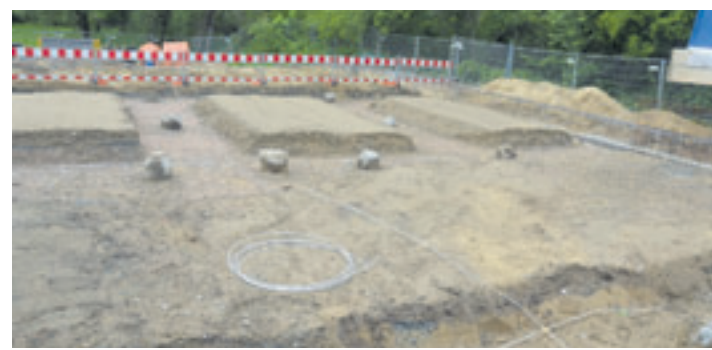
Ist hier eine Grabung des Archäologischen Museums Hamburg zu sehen? Nein, das werden die Fundamente des neuen Feuerwehrhauses der FF Moorburg.
