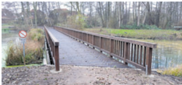
Vom Moorburger Hinterdeich ist die Brücke über die Moorburger Landscheide entlang des Moorburger Kirchdeichs abgesperrt worden, ohne dass dort sichtbare Schäden an der Brücke bestehen. Foto: W. Marsand
