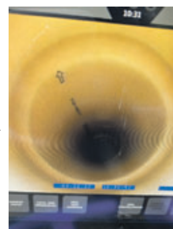
Punktuelle Reparatur eines Rohrbruchs.
