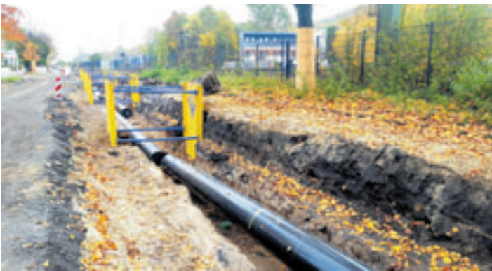
Nach umfangreichen Bauarbeiten gilt in der Straße Am Radeland-West, ab Hausnummer 84 bis zur Einmündung des Bostelbeker Damms sowie am Tempowerkring, „Rechts vor Links“ Foto: W. Marsand
