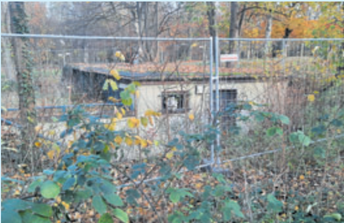
Die alten öffentlichen Sanitäranlagen des Schwarzenbergs sollen abgerissen werden Foto: M.H.
