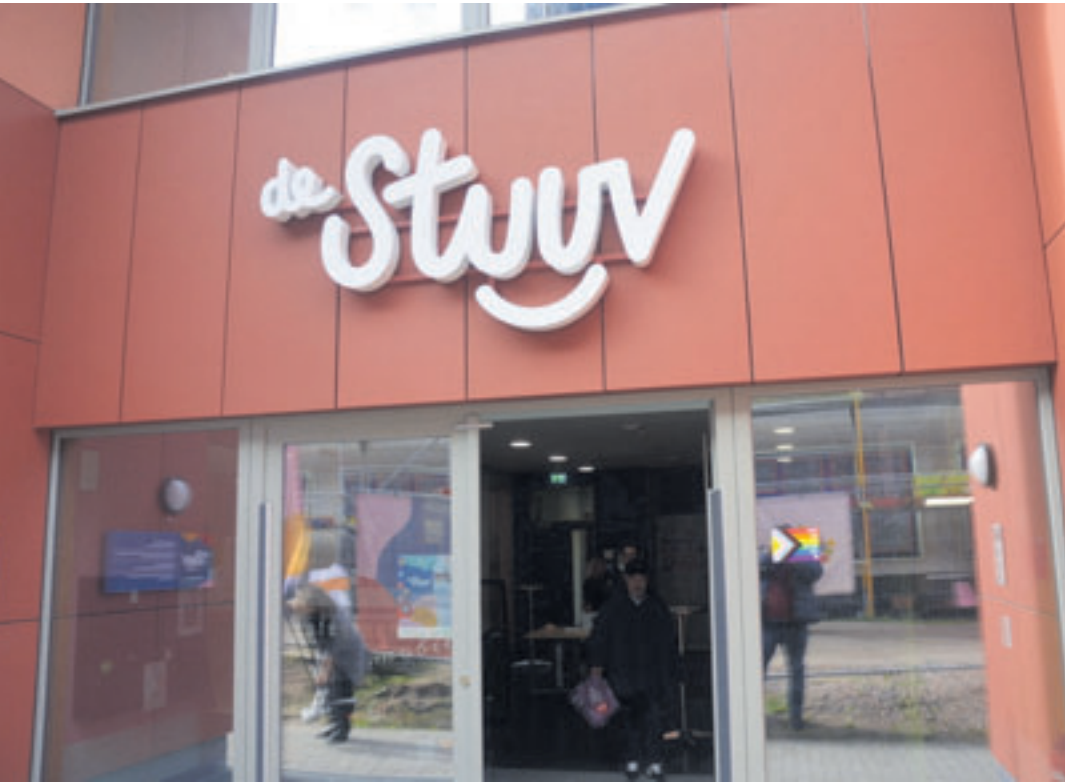
Die CDU fragt nach Fehlern bei der Wärmerückgewinnung beim Quartiershaus „de Stuuv“
