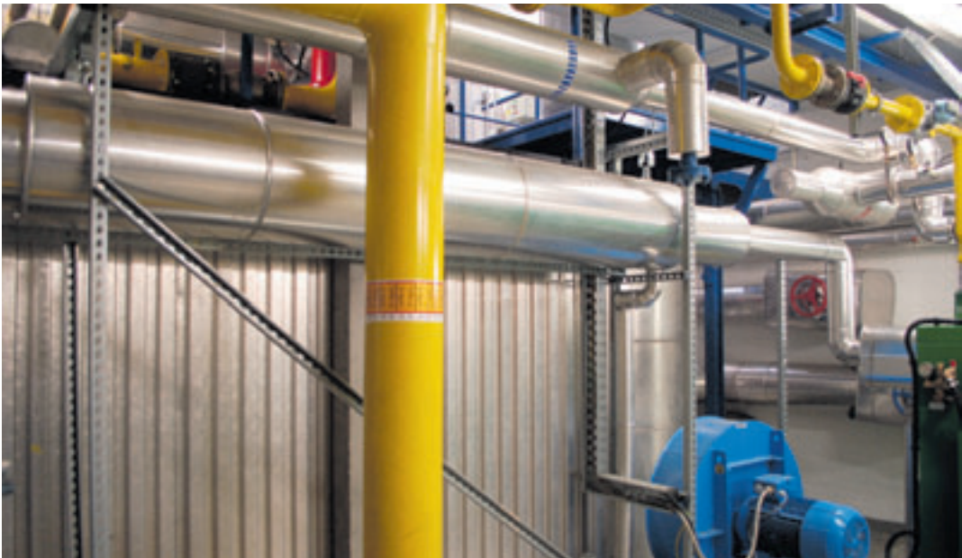
Nach erneuten Heizungs- und Warmwasserausfällen in zahlreichen Haushalten im Bezirk Harburg bringt die Volt-Fraktion in der Bezirksversammlung einen Antrag zur umfassenden Aufklärung der Vorfälle ein. Foto: mk
