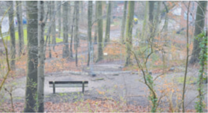
Am 2. November beginnen am Burgberg die Bauarbeiten zur Erneuerung der Treppenanlagen und Wege am Südhang Foto: mk
