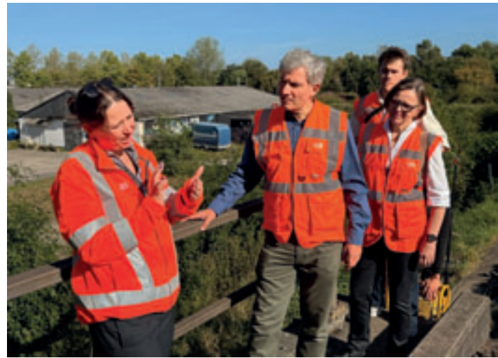
Metin Hakverdi (2.v.l.) bei der Begehung der Süderelbbrücke gemeinsam mit Ute Plambeck (Konzernbevollmächtigte der Deutschen Bahn) und Stefanie Hesel (Projektleiterin Süderelbbrücken, DB InfraGO) Foto: SPD
