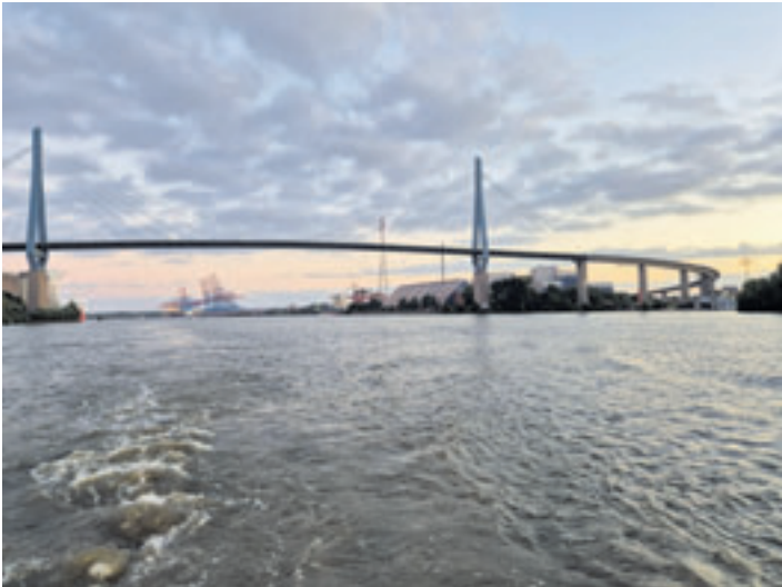
Im September muss die Köhlbrandbrücke gleich an zwei Wochenenden voll gesperrt werden Foto: au
