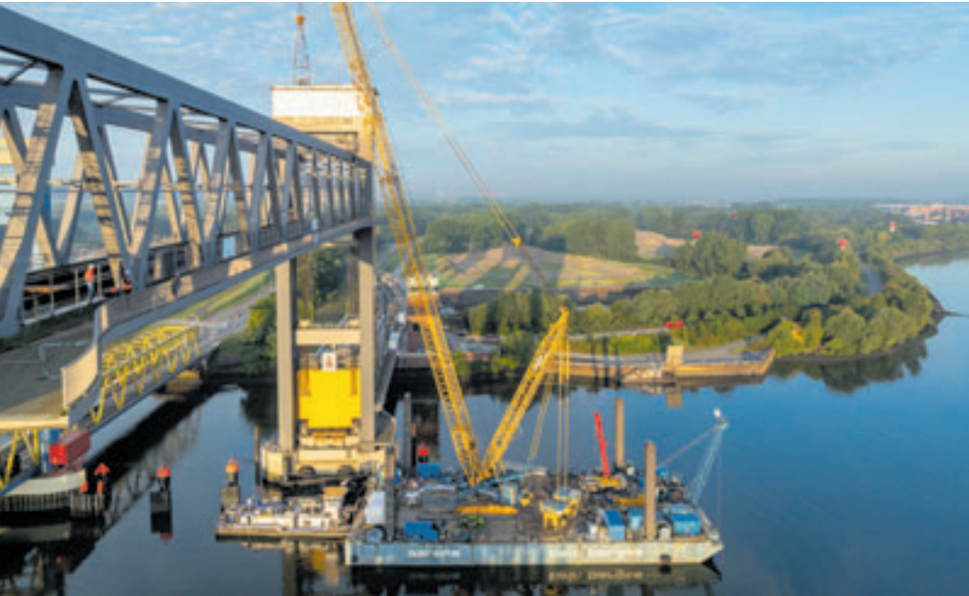
Der Trommeltausch an der Kattwykbrücke erfolgte mithilfe eines auf einem Ponton eingesetzten Großkrans mit einem rund 130 Meter langen Ausleger Foto: HPA/Jan Sieg
