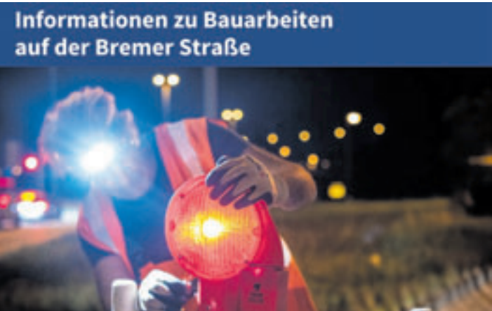
Maldfeldstraße wieder frei – dafür Sperrung in Richtung Vahrenndorf Foto: Deutsche Autobahn GmbH
