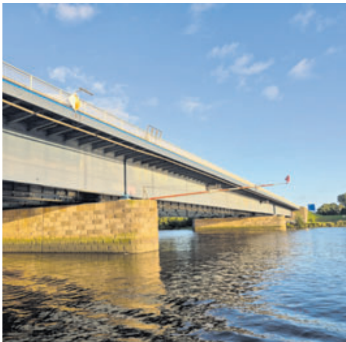
Die Süderelbbrücke muss erneuert werden. Derzeit finden zahlreiche vorbereitende Arbeiten statt
