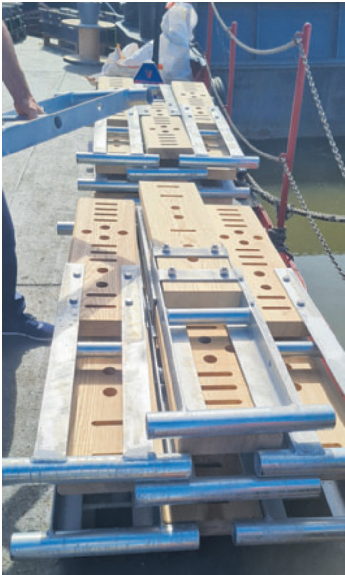
Unterschiedlich große Bohrlöcher, Rillen und Kerben in den Bohlen bieten Würmern, Krebsen & Co. Unterschlupf Foto: Fabelzucker
