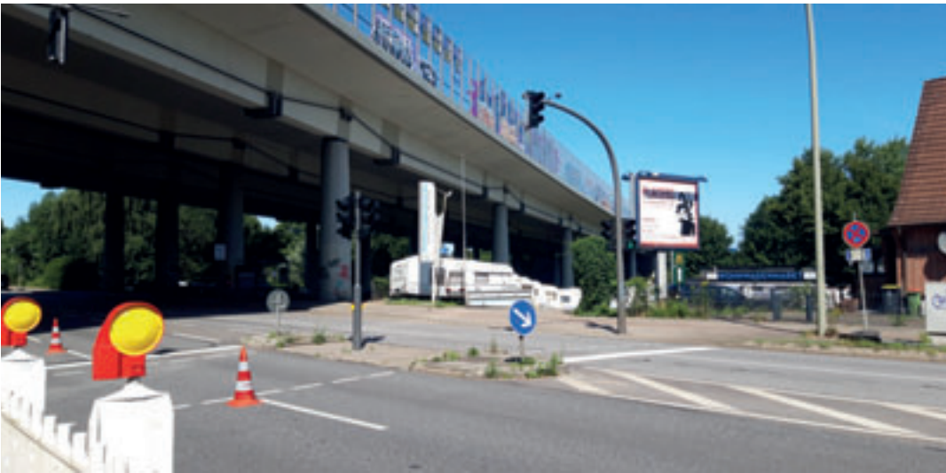
In der Nähe der Autobahnbrücke der A7 soll das Zugunglück passiert sein.
