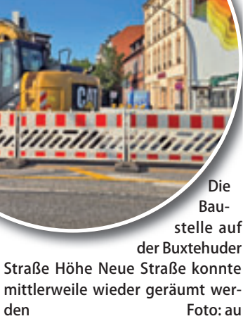
Die Baustelle auf der Buxtehuder Straße Höhe Neue Straße konnte mittlerweile wieder geräumt werden
