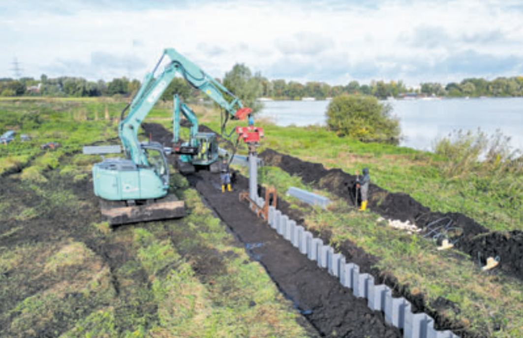
Um das Versickern dauerhaft zu verhindern, wurde eine rund 700 Meter lange und bis zu vier Meter tiefe Kunststoff-Spundwand eingebracht
