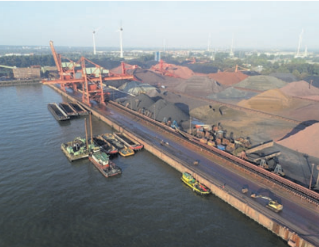
Der Salzgitterkai im Sandauhafen wird saniert
