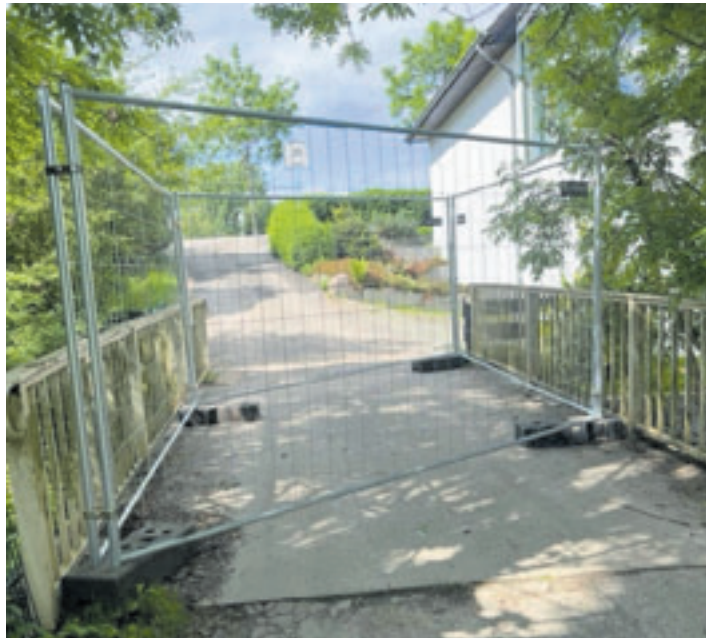
Die Brücke über die Neuländer Wettern ist nur kurz, aber für das Quartier enorm wichtig, nun versperrt ein Bauzaun den Weg Foto: ein
