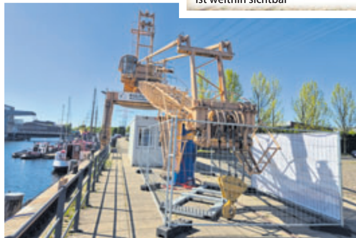
Zum offiziellen Baustart wurde der riesige Ausleger abgesenkt
