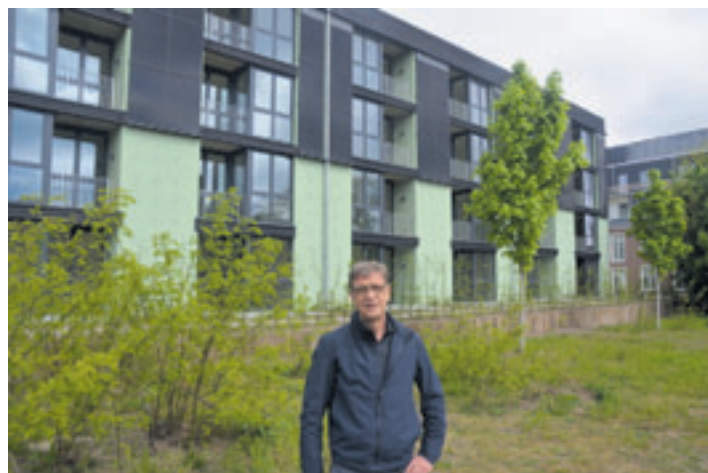
Bauherr und Investor Matthias Korff vor dem Smoodje-Neubau: Photovoltaikmodule auf Süd- und Westfassade sorgen für Energieautarkie Foto: mk
