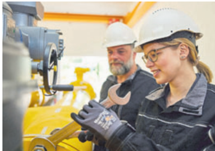
Arbeiten an einer Gasdruck-Regelanlage. Mit zusätzlichen Einbauten bereiten die Hamburger Energienetze ihre Anlagentechnik in Harburg auf die kommende Heizsaison vor Foto: Hamburger Energienetze
