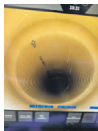
Punktuelle Reparatur eines Rohrbruchs.
