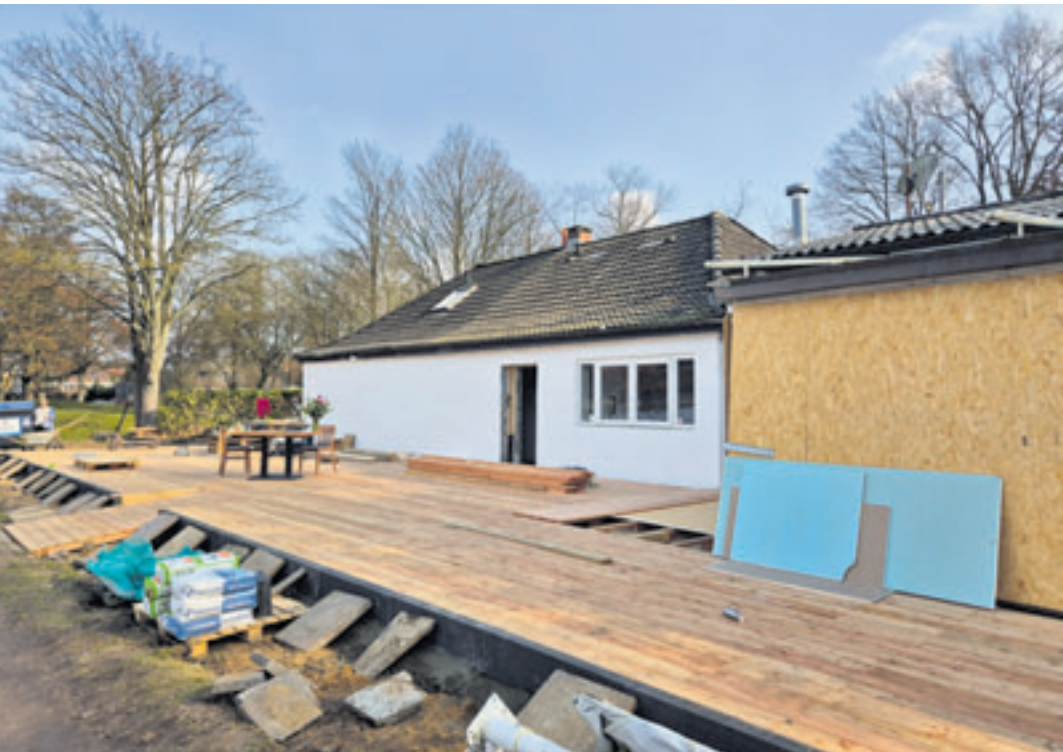
Im Inneren und rund um das Bootshaus an der Außenmühle wird noch fleißig gewerkelt. Nur noch wenige Wochen, dann soll eröffnet werden Fotos: au
