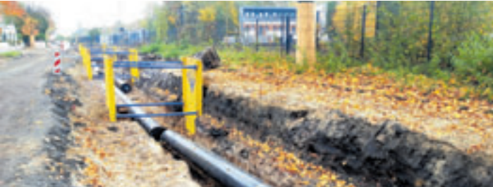
Nach umfangreichen Bauarbeiten gilt in der Straße Am Radeland-West, ab Hausnummer 84 bis zur Einmündung des Bostelbeker Damms sowie am Tempowerkring, „Rechts vor Links“ Foto: W. Marsand
