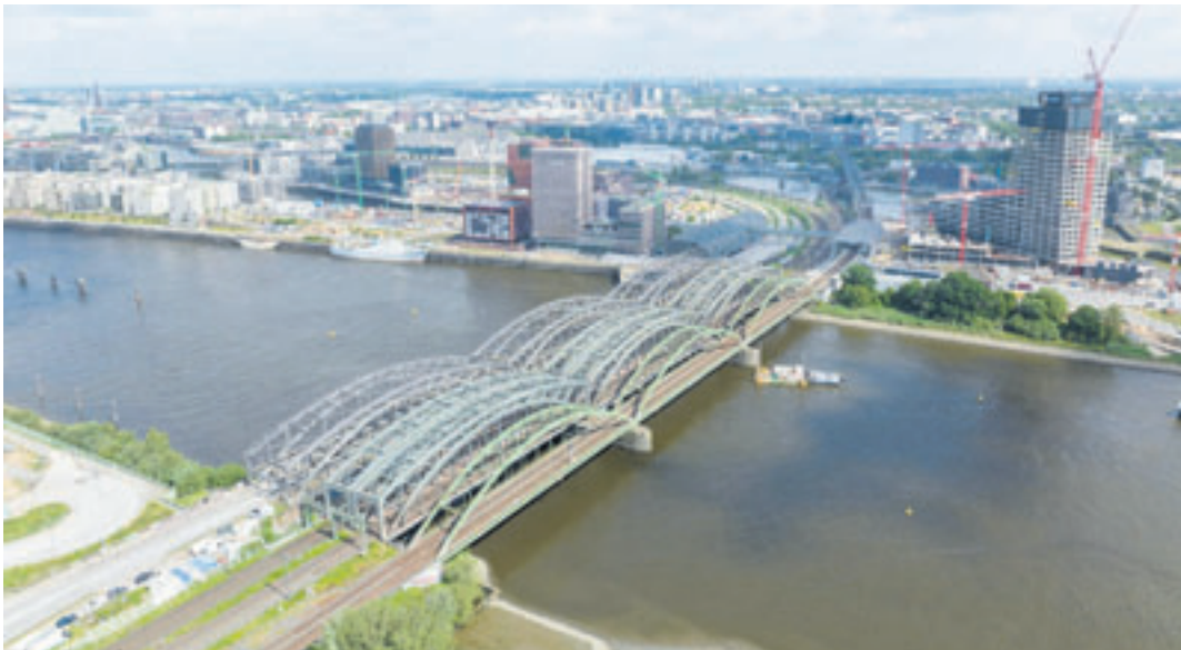
Die Eisenbahnbrücke über die Norderelbe: Derzeit führen vier Gleise über das Gewässer. Links daneben die Freihafenelbbrücke, die aufgrund eines Unfalls gesperrt ist Foto: Deutsche Bahn AG
