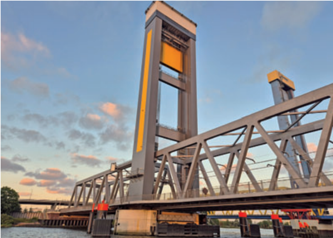
Wegen planmäßiger Instandsetzungs- und Optimierungsarbeiten an der Maschinentechnik sowie begleitende Arbeiten im Gleisbereich der Südbahn wird die Neue Bahnbrücke Kattwyk im Sommer für mehrere Wochen gesperrt Foto: au
