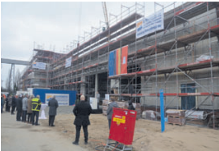
Neben dem derzeit im Bau befindlichen neuen Standort der Feuer- und Rettungswache Finkenwerder (zukünftig im Bezirk Harburg)...
