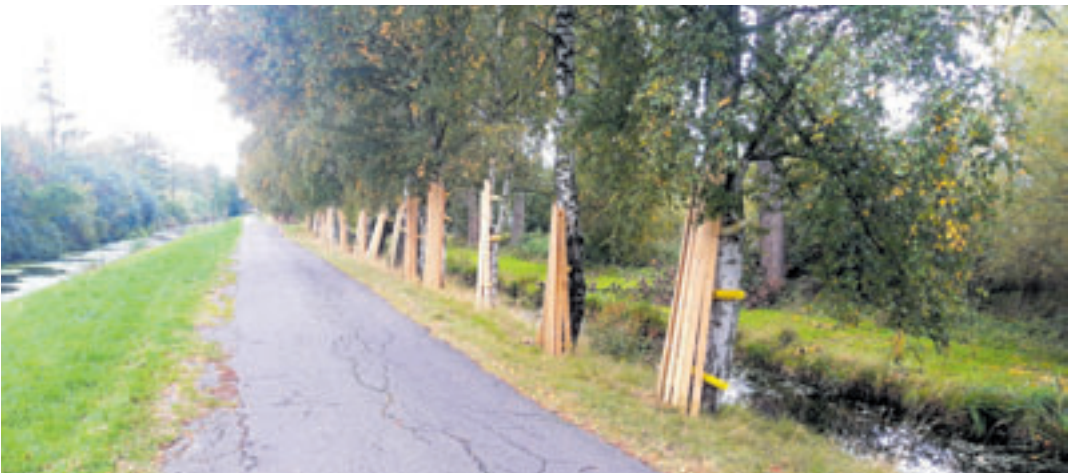
Seit November 2025 ist der Radweg-Abschnitt zwischen Waltershofer Straße und der A7 nun vollständig gesperrt Foto: W. Marsand
