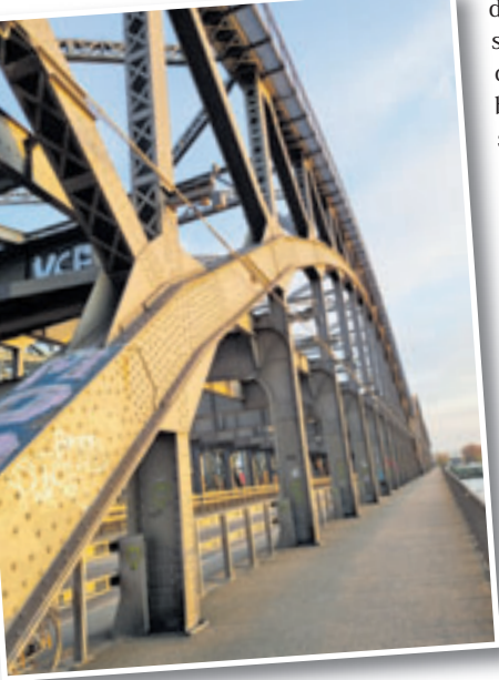
1926 wurde die Freihafenelbbrücke erbaut und gilt laut Denkmalverein als besondere Konstruktion Foto: au
