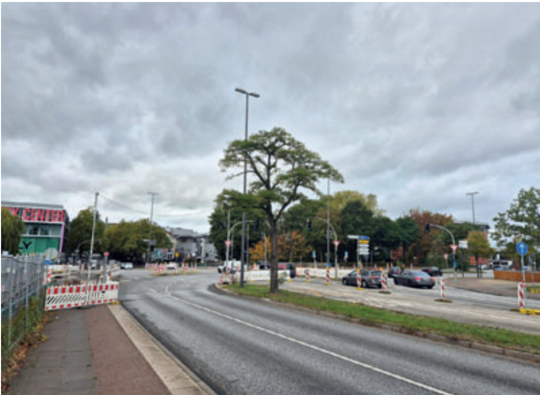
Der Harburger Doppelknoten soll demnächst saniert werden. Dafür müssen Bäume gefällt werden. Geht es nach SPD und Grüne, sollen möglichst große Bäume nachgepflanzt werden Foto: au
