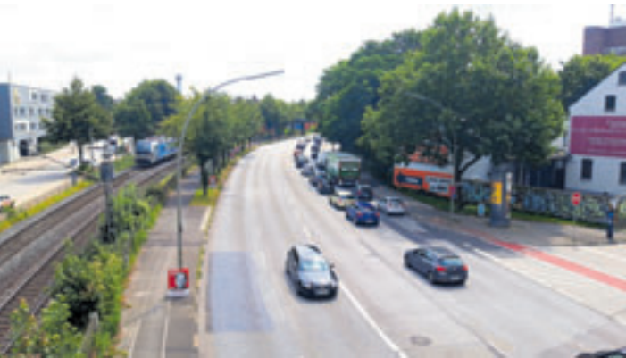
Der marode Radweg an der B73 bis zur Seehafenbrücke soll laut BVM erst später saniert werden Foto: W. Marsand
