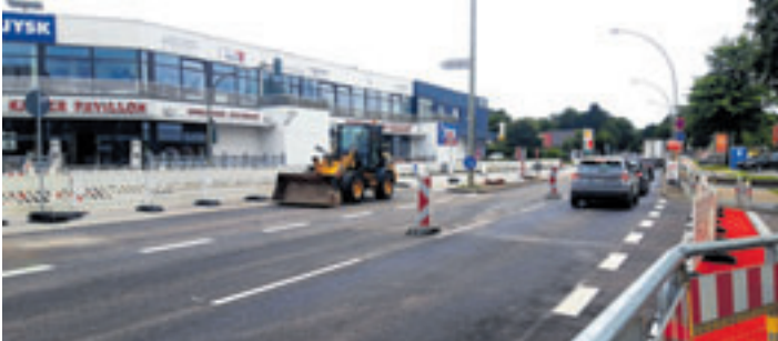
Vom 11. bis 30. Oktober werden in den Herbstferien die Kreuzungen in der Cuxhavener Straße Fischbeker Heuweg/Scharlbarg/Süderelbebogen/Neugrabener Bahnhofstraße erneuert
