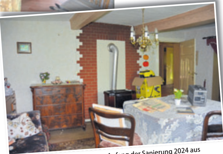
So sahen die Räumlichkeiten am Anfang der Sanierung 2024 aus
